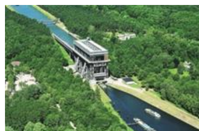
das-schiffshebewerk-niederfinow ©WSA Eberswalde
